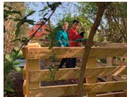
Stavba kompostéru na zahradě školy
